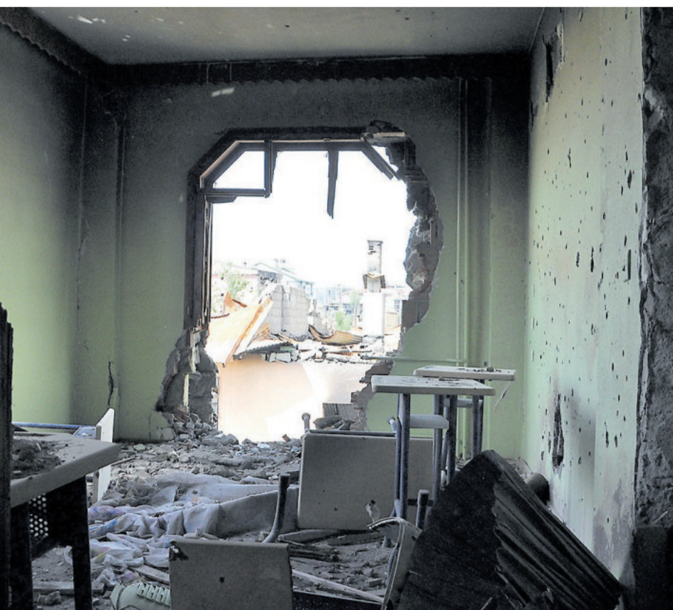
Blick aus einem Haus in Yüsekova, das vom türkischen Militär beschossen wurde.
